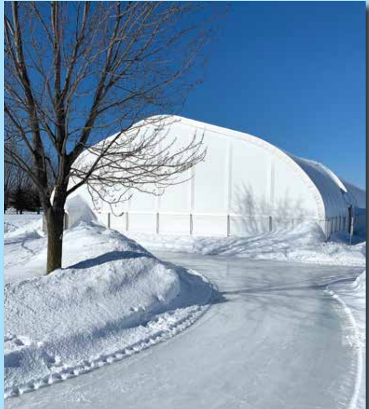
LES TRAVAUX DE RÉNOVATION SONT COMMENCÉES AU CENTRE COMMUNAUTAIRE
